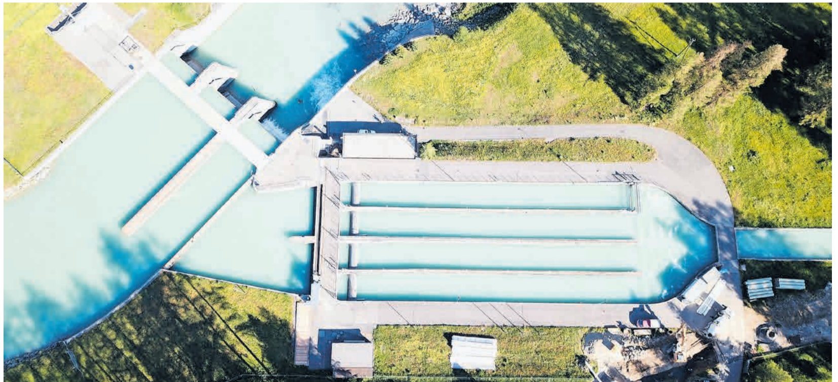
Die Wasserfassung der Engadiner Kraftwerke AG in S-chanf: Links der Inn-Zulauf bis an die drei Stauklappen mit Inn-Restwasserregime (links) und Fischtreppe (rechts davon). Bildmitte: Zulauf Wasserfassungen EKW mit den vier langen Entsandungsbecken und dem Abflusskanal Richtung Ova Spin. Foto: EKW AG
