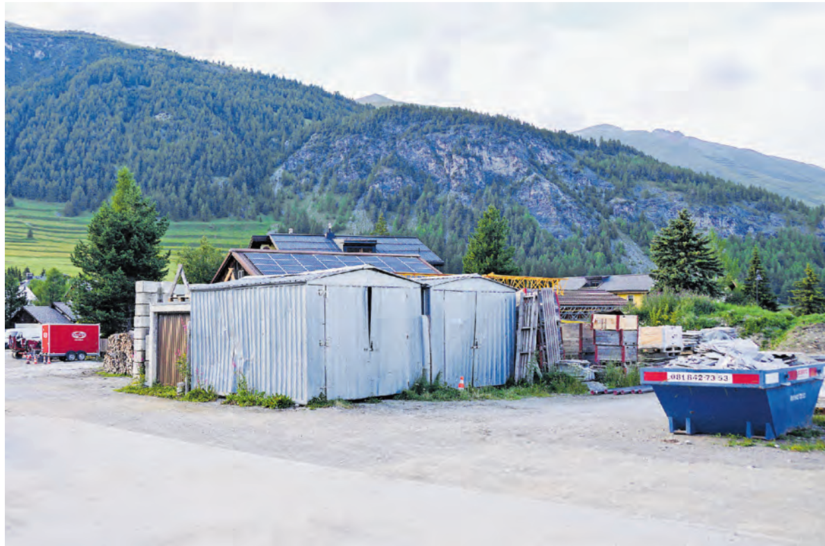
Auf diesem Areal im Quartier Truochs/La Resgia in La Punt Chamues-ch soll nach den Plänen der «InnHub»-Promotoren bereits Ende 2022 ein Innovationszentrum mit internationaler Ausstrahlung eröffnet werden. Foto: Jon Duschletta
